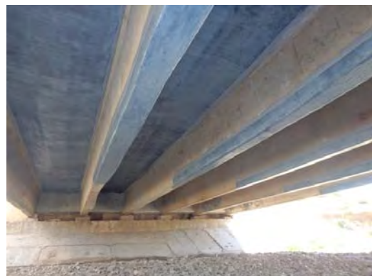
写真 2.4.51 主桁補強後(ID-41)
