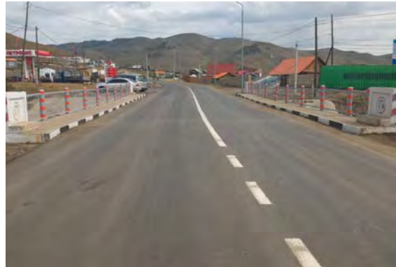
写真 2.4.45 補修後(橋面:ID-41)
