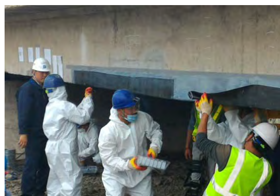
写真 2.4.43 CFRP による補強工法の施工技術支援
