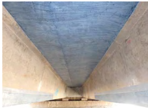
写真 2.4.49 床版補強後(ID-41)
