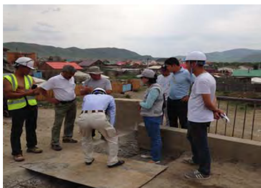
写真 2.4.38 C/P 職員との現場協議の様子
