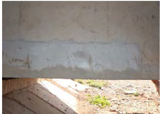
写真 2.4.47 断面修復後(ID-41)
