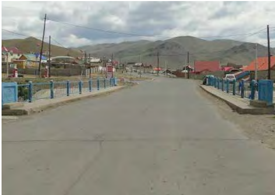
写真 2.4.44 補修前(橋面:ID-41)
