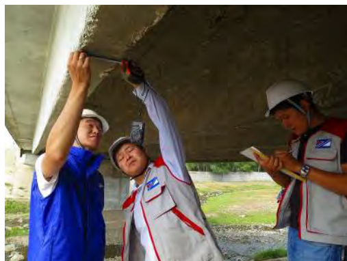
写真 2.4.3 UBC 自主点検の状況
