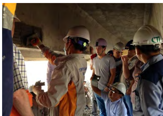
写真 2.4.42 断面修復工事の施工技術支援
