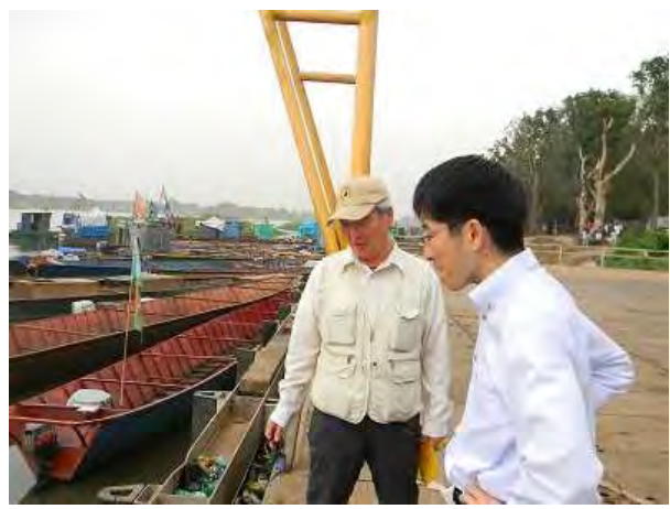
ジュバ港棧橋視察状況
