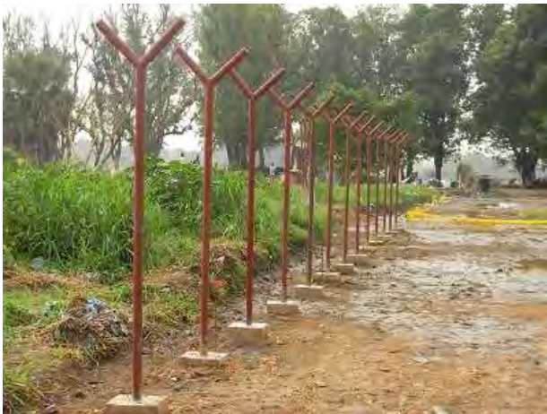
セキュリティフェンス設置予定場所
