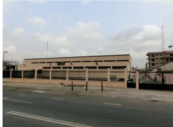
本計画対象サイト①(グラフィックロード一次変電所)
