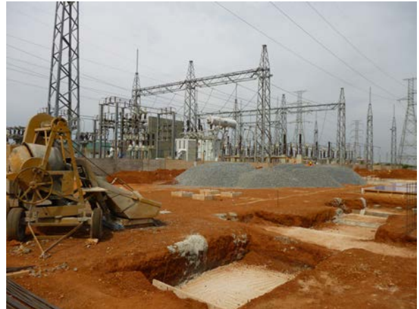
既存の A3 境界変電所(変電容量:132 MVA)
