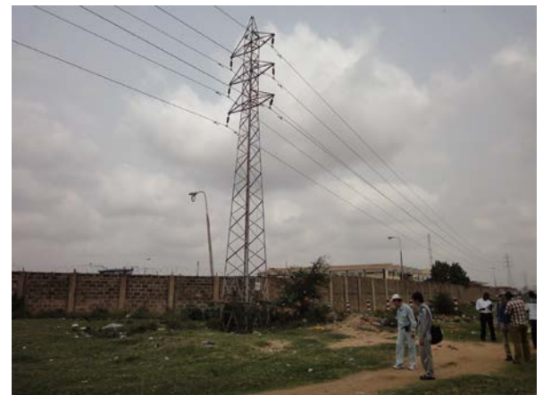
既存の 33 kV 準送電鉄塔(計画対象地周辺)
