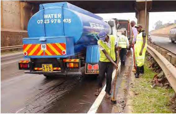
PBCによる道路維持管理〔ティカ(Thika)道路〕
