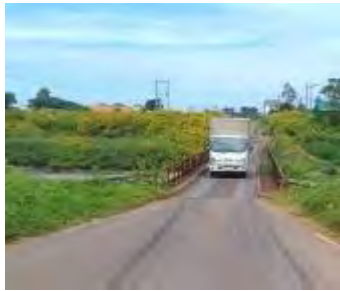
① Đường kết nối duy nhất đến KCN Phú Hội - Xe Công tenơ 40 Fit không đi qua được
