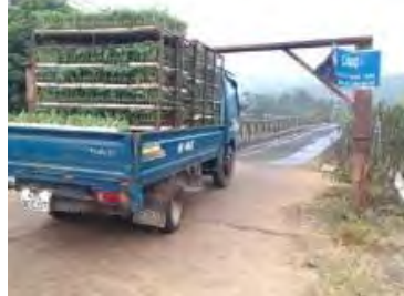
② Đường từ QL27 đến Cụm CN Ka Đô, cầu sắt đã cũ kỹ nên bị hạn chế về tải trọng
