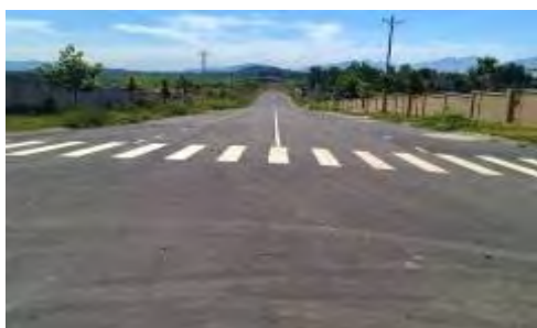
Đường trong KCN Lộc Sơn Cơ sở hạ tầng về đường rất tốt
