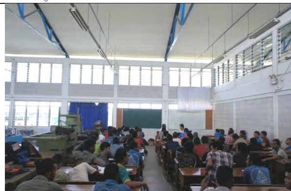
写真-5：土木学科ワークショップ棟。実習スペースであった空間を教室として利用している。教室と実習スペースを隔てる壁がない。実習の騒音等で授業に集中できる環境にない。
