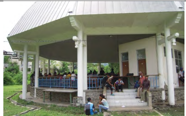
写真-12：食堂棟。現状の工学部ヘラキャンパスには適当な集会室がないことから、入学式などに使用している。規模及び設え共に集会には不適である。
