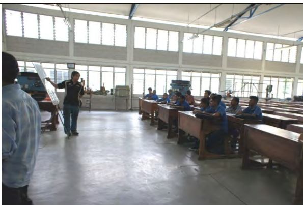
写真-3：機械工学科ワークショップ棟。実習スペースであった空間を教室として利用している。周囲と一体的な空間であることから、周囲の音や生徒等の往来で授業に集中できる環境にない。
