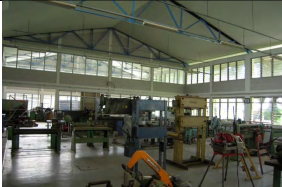
写真-9：機械学科ワークショップ棟。故障したまま存置されている実習機材が散見される。
