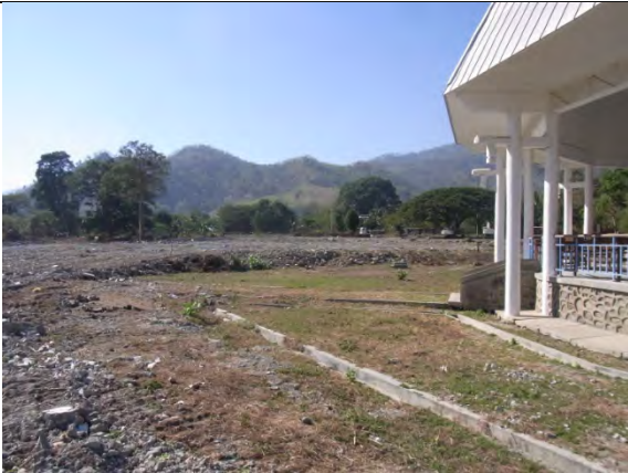
写真-1：計画敷地。独立時の騒乱により全焼した廃屋が残置されていたが、大学側によって解体が完了。右手手前に見えるのは食堂棟。
