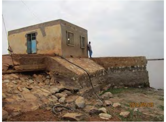
写真 - 2 : 1990年代に建設された突堤式の取水施設。ここから50m程度取水管が白ナイル川に延伸している。
