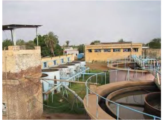
写真 - 4 : 老朽化が進む既存浄水施設（円形沈殿池、急速ろ過棟）
