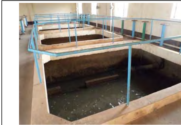
写真 - 7 : 1990年代に建設された鉄筋コンクリート製の急速ろ過池。ろ材が適切でなく、洗浄頻度も低いため、状態はきわめて悪い。
