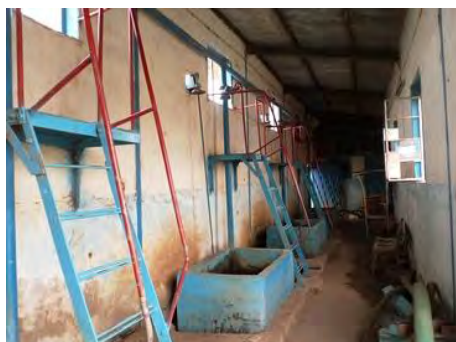
急速ろ過棟 B の内部
