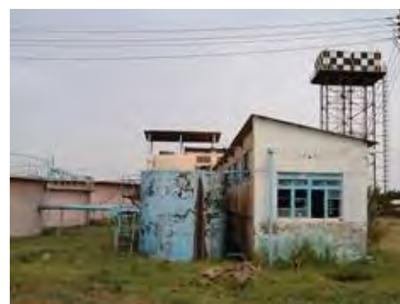
急速ろ過棟 B の全景
