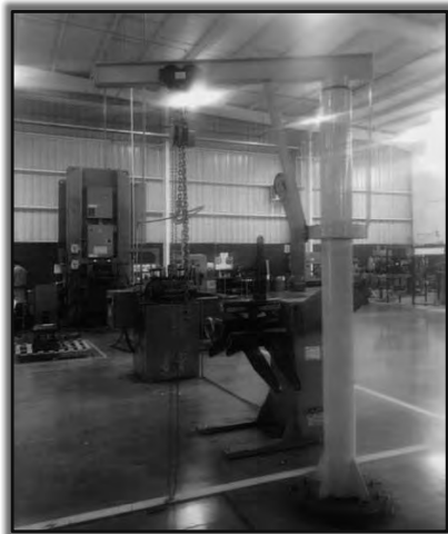
Instalación de Polipasto para manejo de aceros
