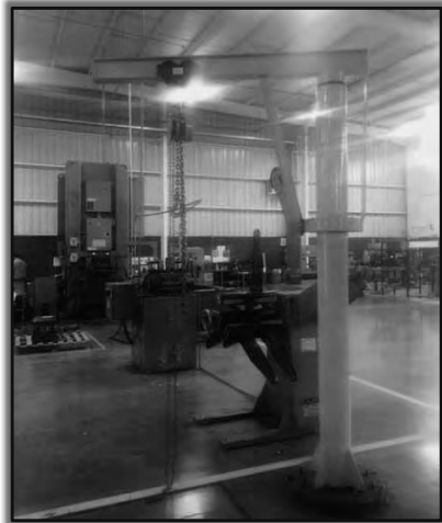
Instalación de Polipasto para manejo de aceros
