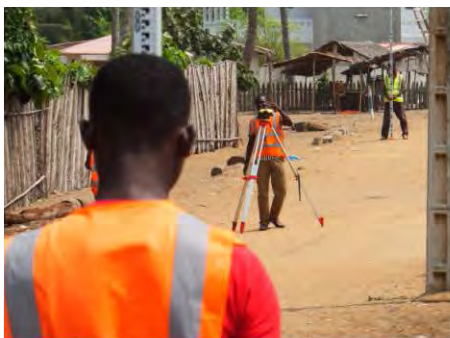
Levé de Point de Calage au Sol (nivellement)
