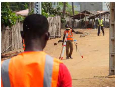
標定点測量（水準測量）
