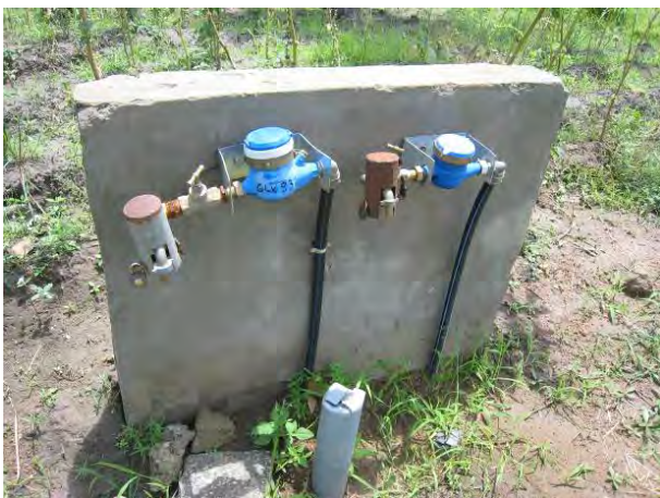
グラズエ市内の各戸給水栓。蛇口の部分に錠が掛けられており、契約者が水栓を管理。周辺の住民と共同で利用している場合も多い。
