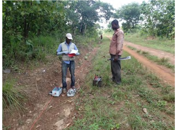
水源井戸の試掘地点を決定するための電気探査作業風景。選定したグラスエ市及びダッサズメ市の周辺地域の7つの地下水開発区で実施した。
