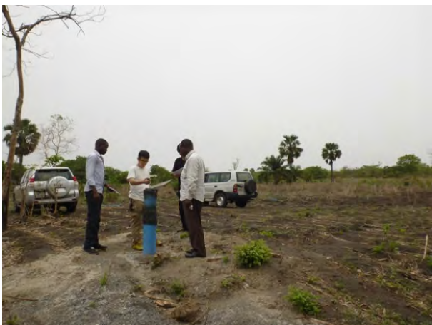
市の担当者と送水管の布設路線を確認。予定の配管ルートを踏査し、既存道路、公有地、民地等の別や配管に係る問題の有無を確認した。
