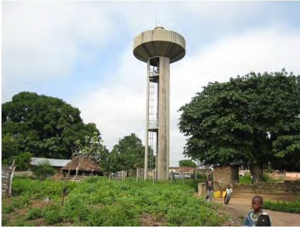
グラズエ市の既存高架水槽（75m 3 ×16.5m）。送水管と配水管が分離されていない圧力調整槽で、水需要の少ない時間帯に配水管から逆送、貯水される。
