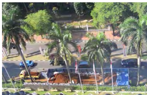
既存技術による立坑工事（全景）
