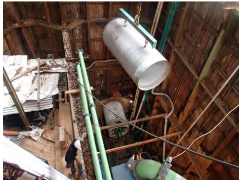
写真 19 : 推進管の接続
