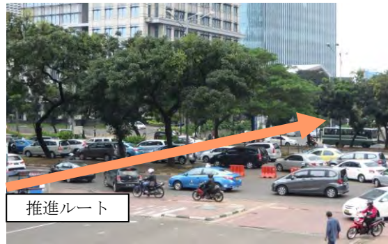
写真2：推進工事現場周辺
