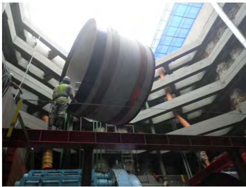
3500mm管を据付
