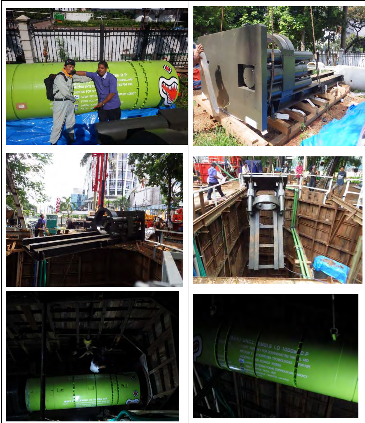
図 3.1.5 掘進機・元押据付
