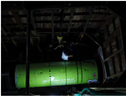
写真 15 : 掘進機据付
