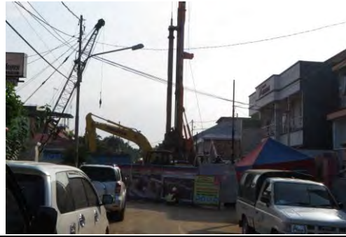
到達立坑工事（中間立坑）
