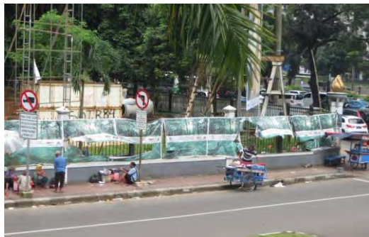
写真1：推進工事（発進立坑）
