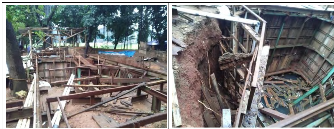
図 3.1.1 発進立坑冠水状況
