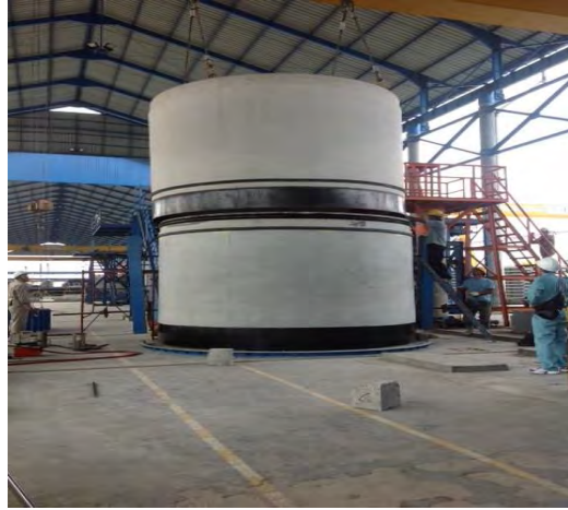
推進管製作・組み立て試験
