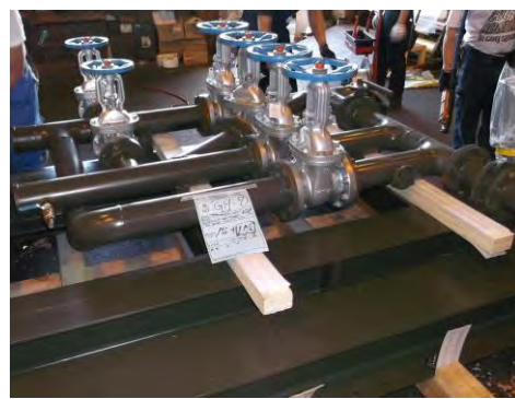
写真8：立坑バイパス
