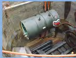
自社開発の掘進機「アングルモール エル」
