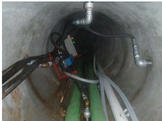
写真 18 : 管周混合装置・滑材注入
