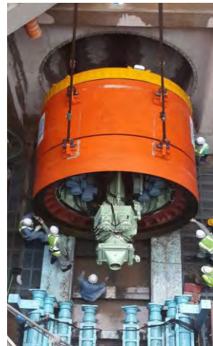
直径 3500 掘進機据付
