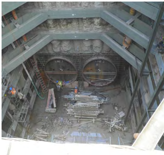
発進立坑構築
