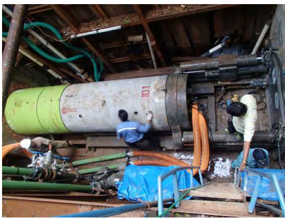
写真 17 : No1 パイプとの接続
