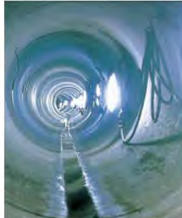
φ800 曲線100R管内状況
