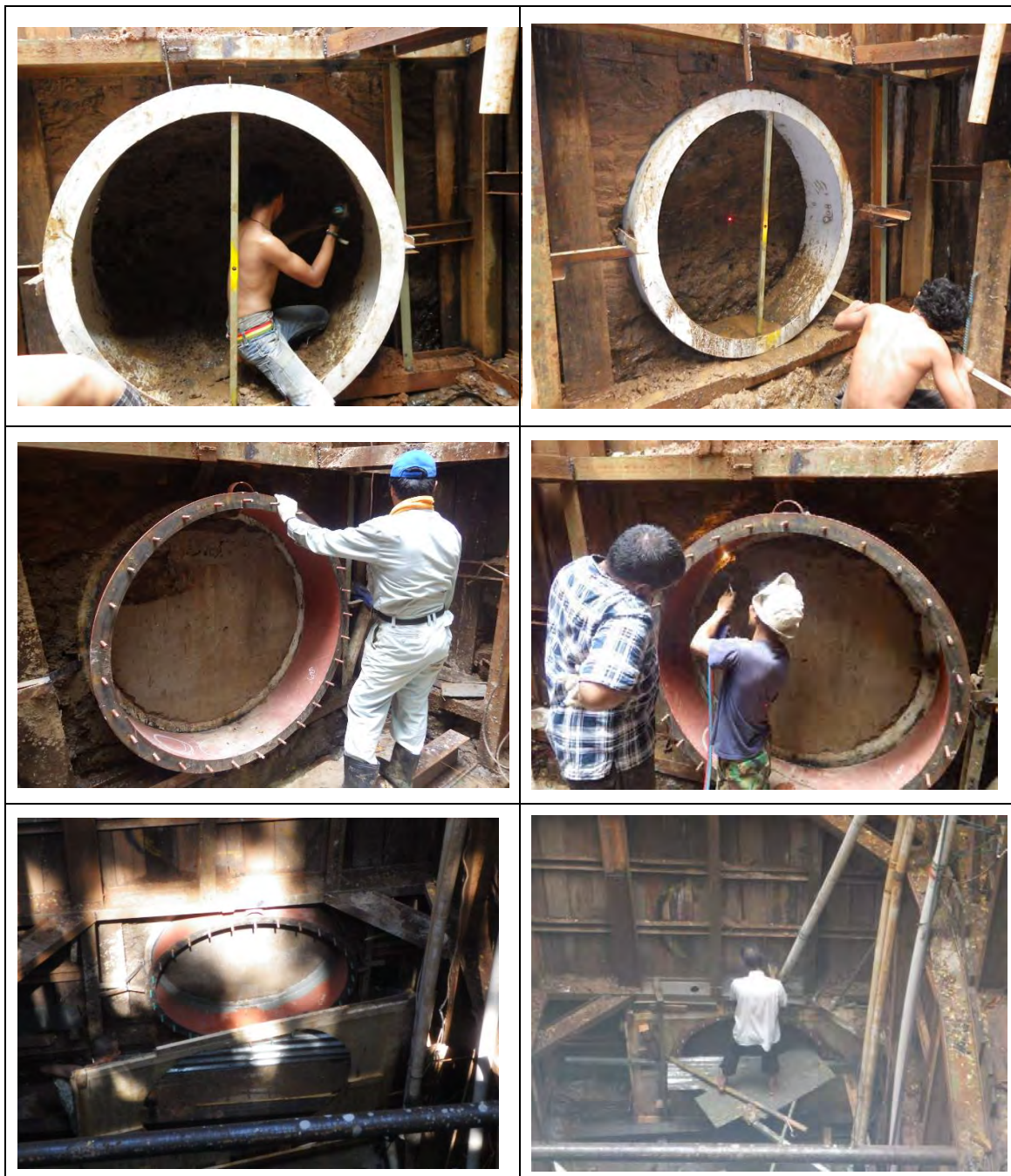
図 3.1.4 坑口リング取り付け
