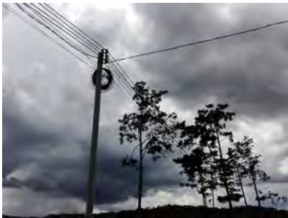
事業候補地に敷設されている電線
