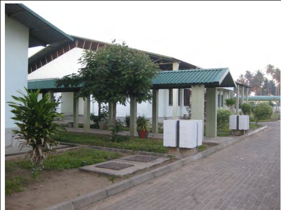
写真 10: ICS キリマネ外観 我が国の無償資金協力により 2007 年に竣工した「モ」国中部ザンベジア州にある ICS。状態はおおむね良好である。
