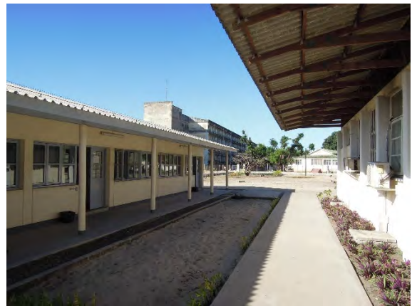
写真 9: ICS ベイラ教室棟 我が国の無償資金協力により 2010 年に竣工した教室棟、全 4 教室が増築された。状態はおおむね良好である。
