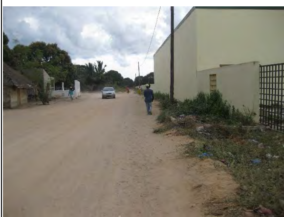
写真 2: プロジェクトサイト前面道路
