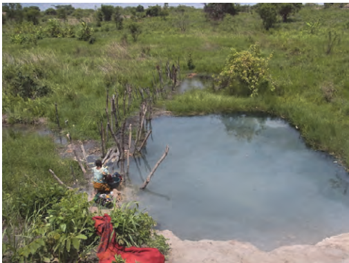
簡易堰（写真上部が上流、堰で流れをせき止め、写真左の取水口に水が流れる）
