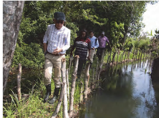
簡易堰堰堤（歩いているのは堰堤部分）
