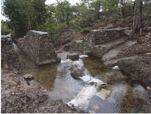
建設中の恒久堰
