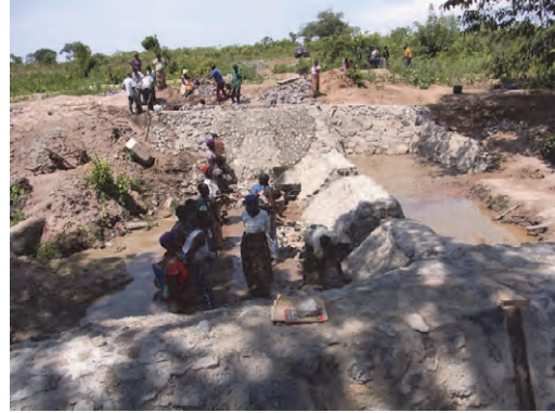
住民参加による恒久堰の建設
