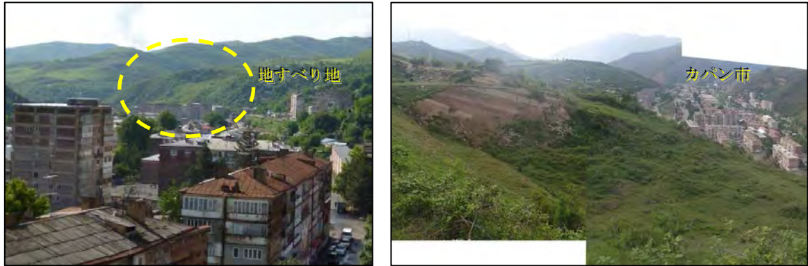
写真 2-5-18 カパン地すべり全景（調査団撮影）
