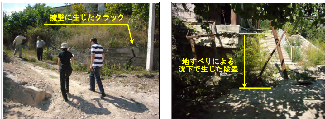
写真 2-5-21 被災・修復後の道路（左）と段差の生じた住居の中庭（右）調査団撮影
