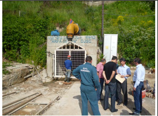
地すべり地 (ディリジャン) 水抜きトンネル施工状況
