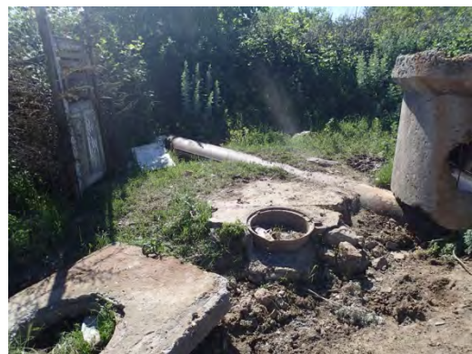
写真 2-5-5 主な誘因とされる水道管からの漏水
