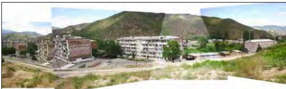
写真 2-5-20 地すべり内から見た下方の道路・建物（JICA 開発調査報告書より引用）
