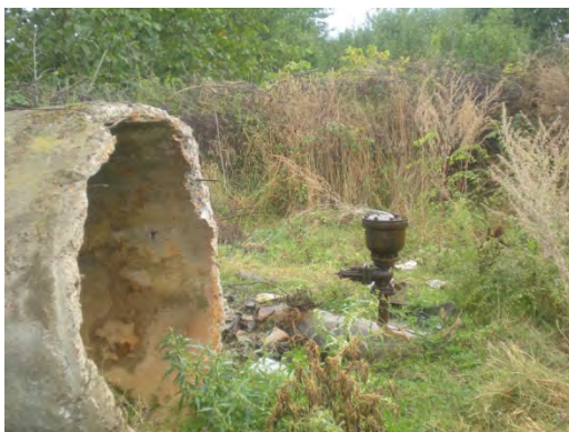
写真 2-5-5 主な誘因とされる水道管からの漏水
