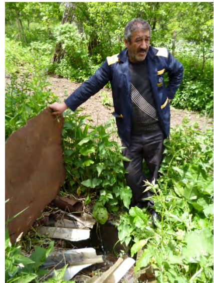
地すべり地 (マルトゥニ村) JICA 開発調査にて設置された水抜きボーリング
