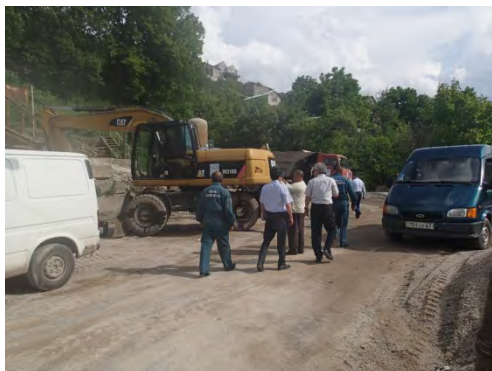
写真 2-5-12 施工機材 (調査団撮影)
