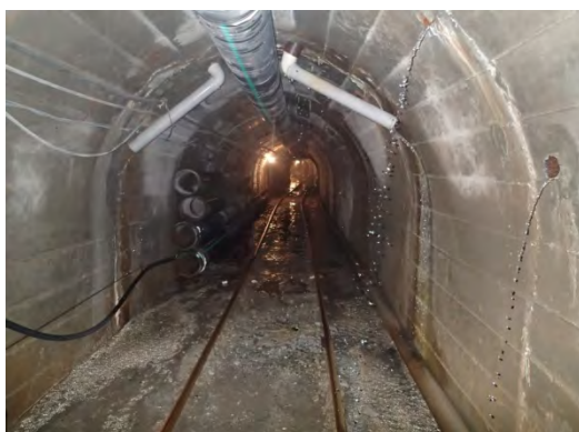
写真 2-5-14 坑内 (コンクリート) 状況 (調査団撮影)
