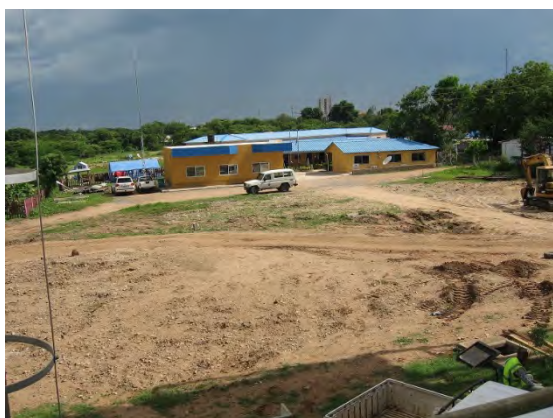
SSUWC 本部の手前の敷地が浄水施設建設予定地
