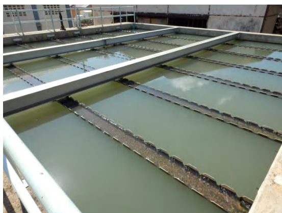
SSUWC ジュバ支所浄水場の沈殿池
