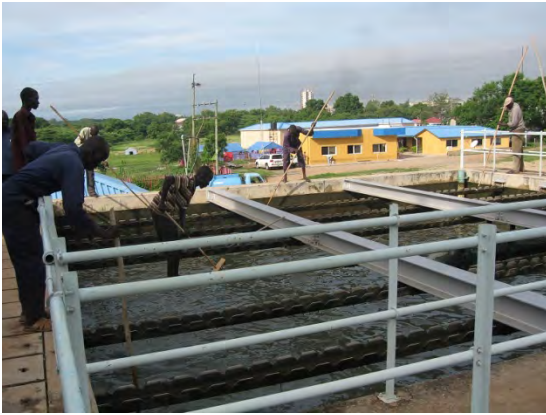
SSUWC ジュバ支所浄水施設の清掃の様子
