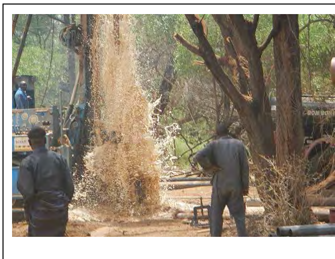
Drilling A Borehole (Turkana)
