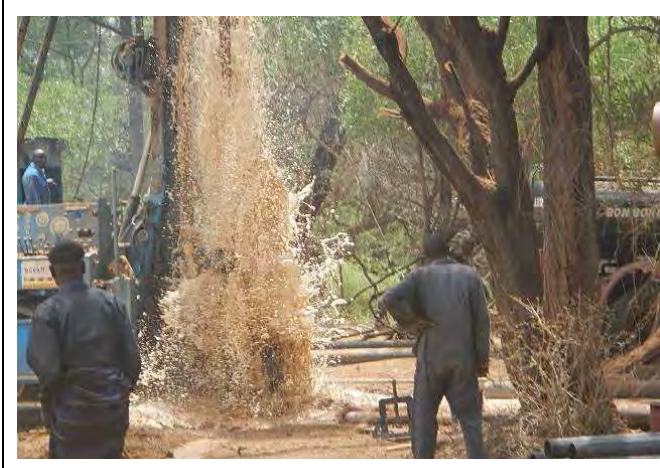
井戸掘削 (トゥルカナ県)
