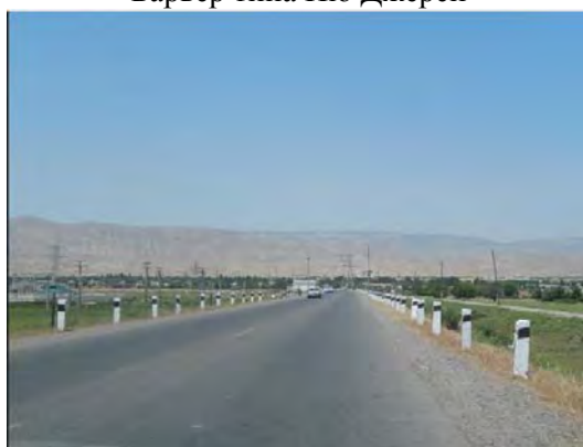
Бетонные столбики только на участке насыпи (без кабелей)
