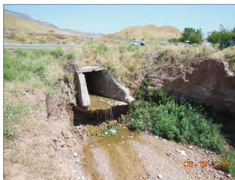
ФОТО 6.6-1 НЕКОТОРЫЕ СОСТОЯНИЯ ТРУБ СО СТОРОНЫ ВЫХОДА
