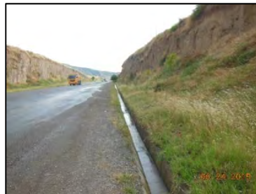
(b) コンクリート側溝
