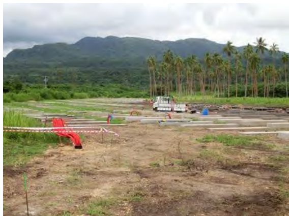
・基礎工事状況
