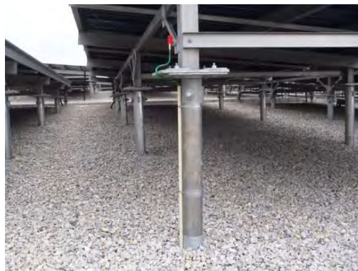
図 3-11 スパイラル鋼管パイル (沖縄本島安部メガソーラー実証研究設備 PV 基礎)
