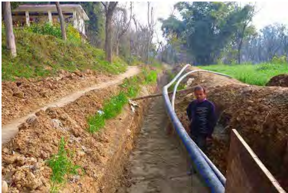
パイプ敷設前検査 (フェーズ 1)
