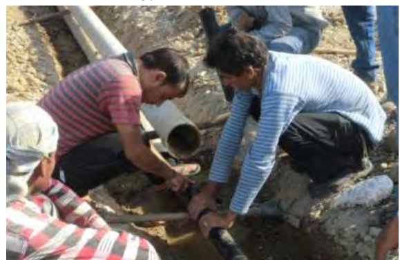
水利組合に対するフィールドサポート パイプラインの漏水修理(フェーズ 3)
