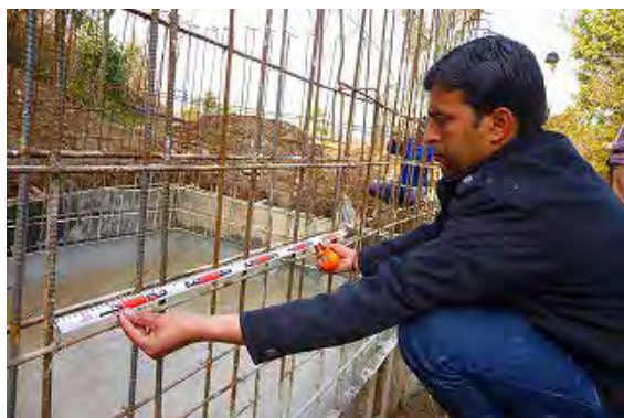
写真による進捗確認記録 工事期間を通じて実施
