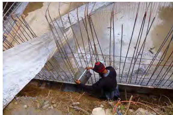
調整水槽の養生風景 (フェーズ 1)
