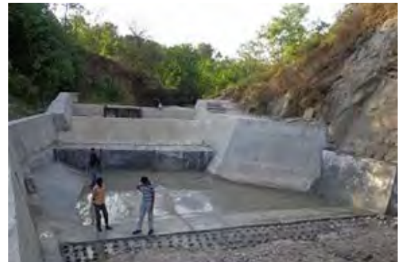
取水堰の下流側エプロン増設 (フェーズ 1)
