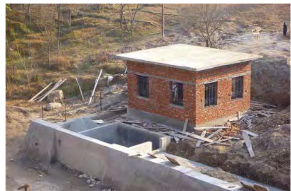
工事中のポンプ室 (フェーズ 1)
