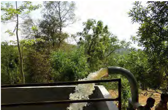
竣工前試運転 (フェーズ 1)
