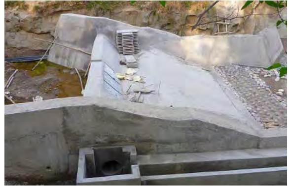
工事中の取水堰 (フェーズ 1)
