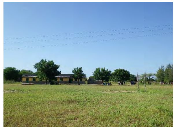
TH-5 : ヤボ ヤボ中学校 (ID:27) 学校敷地に教室棟 (3 教室) とトイレ棟が 2013 年に建設されたが、学校の管理部門やその他の教室は、道の反対側にある地域の研修施設の建物を利用している。併せて、仮設教室や青空教室も利用されている。
