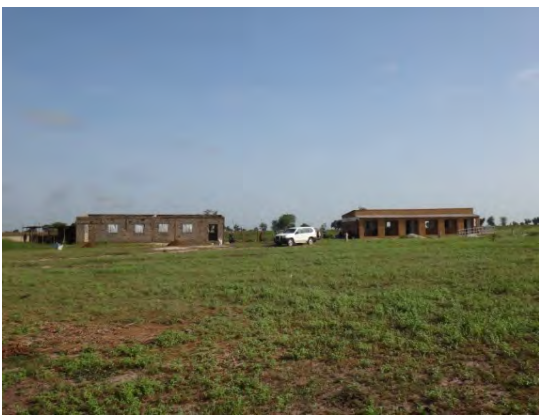
KA-16 : クール ヨロ ホージャ中学校(ID:34) 写真左手の建設中の 2 教室、右手の欧米系 NGO 支援による教室棟 (2 教室) で約 400 人の生徒が就学している。
