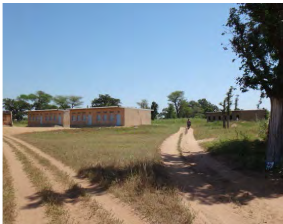
TH-2 : トコマック中学校 (ID:24) 計画対象校は現在公共施設を間借りして運営している。建設予定サイトには現在 2 教室が建設中 (写真中央右奥)。隣に一般無償による小学校 (2004 年建設、写真中央左手) があり、良い状態で維持されている。
