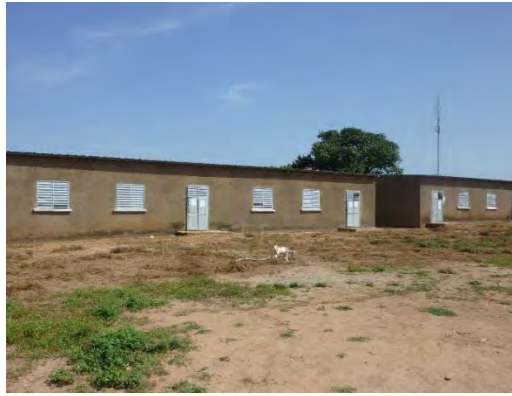
KA-18 : カイモー中学校(ID:36) 既存教室 (2 教室 x 2 棟) は村落共同体により 2010 年に建設された。
