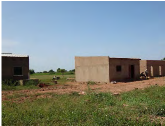
KA-21 : クール セット ジャファー中学校 (ID:39) 写真中央はフランス NGO の援助による 1 教室、右手に建設中の 2 教室 (屋根無し)、校長室、教室と続く。写真左側の建物は隣接する小学校。
