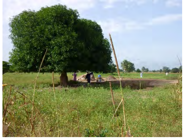
KA-5 : ンブマ中学校(ID:13) 敷地中央に給水栓がある。建設予定サイトには既存施設はなく、樹木が数本点在するのみ。
