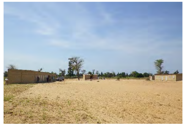
TH-1 : ンジャラオ中学校(ID:23) 幹線道路から未舗装路を約 25 分入った地域の学校。小規模かつ施設のグレードは必ずしも高くないが、非常に良く維持管理されており、清掃状況も極めて良好である。
