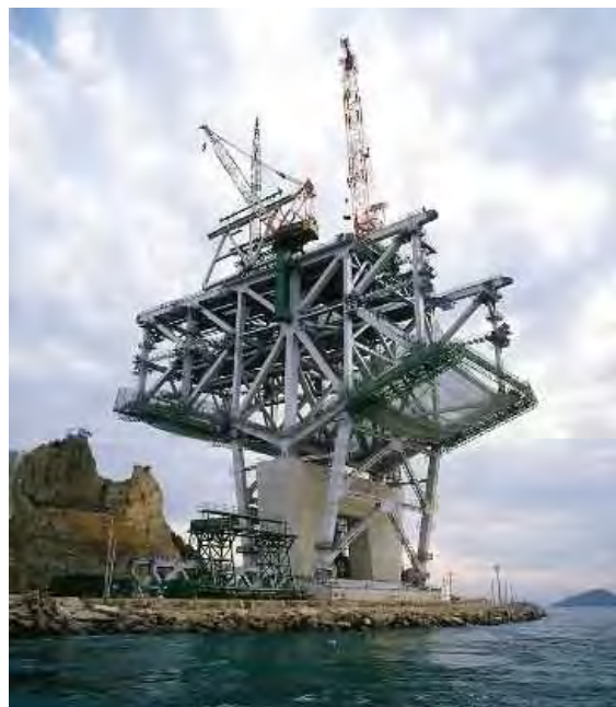
【図 4.1.5】 与島橋単材張り出し架設
