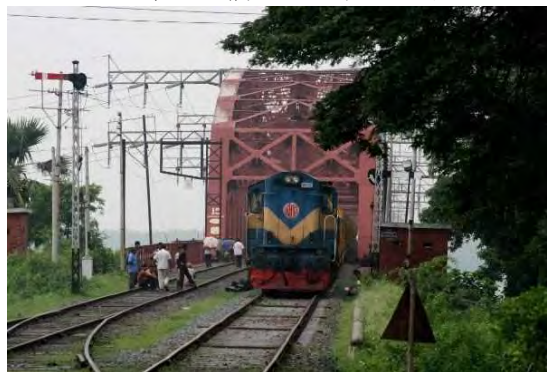
この橋は複線橋として建設されたものの、橋梁の前後区間は単線である。これはこの付近で強風が吹くため耐風安定性も考慮して幅の広い複線橋とされたとのこと。
