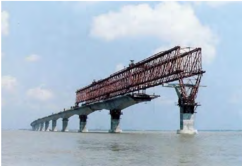
[図 4.1.3] P&Z 工法によるジャムナ多目的橋の架設の状況
