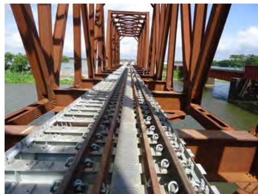
注：橋梁 No.185（スパン 140.3m）
