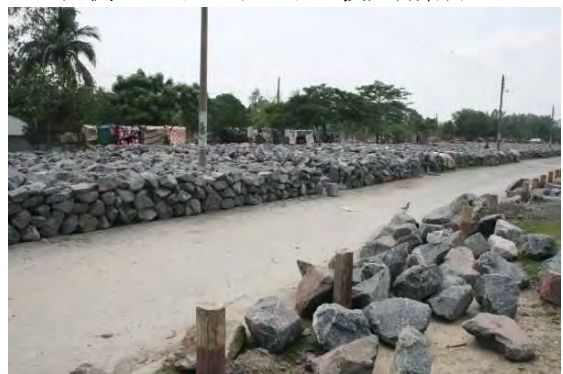
50. 西側ハードポイントの投入用割石
