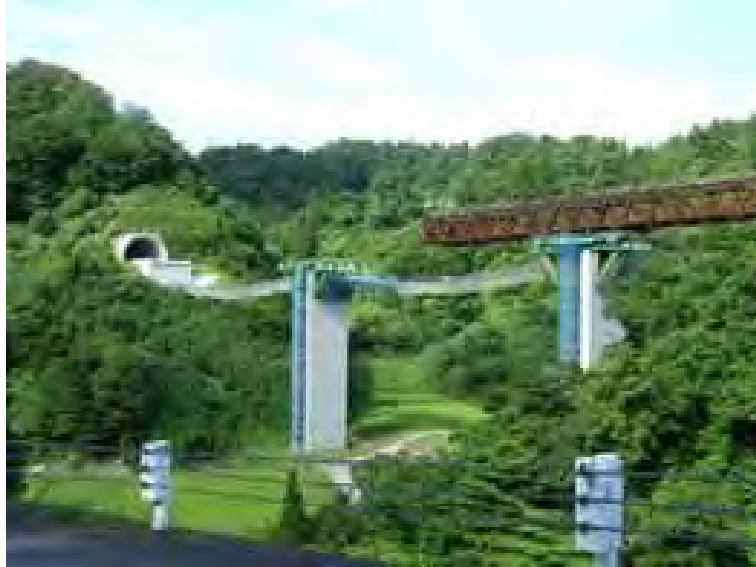
【図 4.1.4】 トラス桁の送り出し架設の状況
