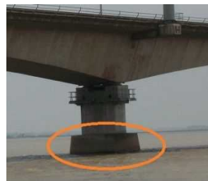
<写真は現橋の橋脚のパイルキャップ部分>
