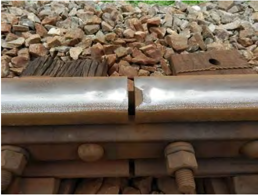
[図 5.1.7] レール欠損事例
