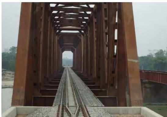
注：橋梁 No.207（スパン 120.5m）
