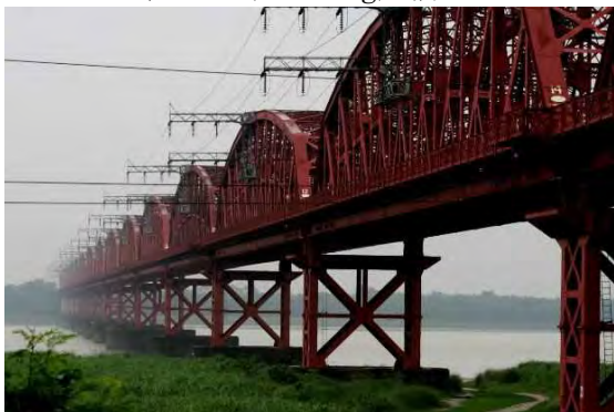
1915年完成。1スパンが110m程度。よく維持管理されている。最後の塗り替えは2012年。下流約280mの位置にパクシー橋 (Lalon Shah Br.) があり、スパン長を合わせている。
