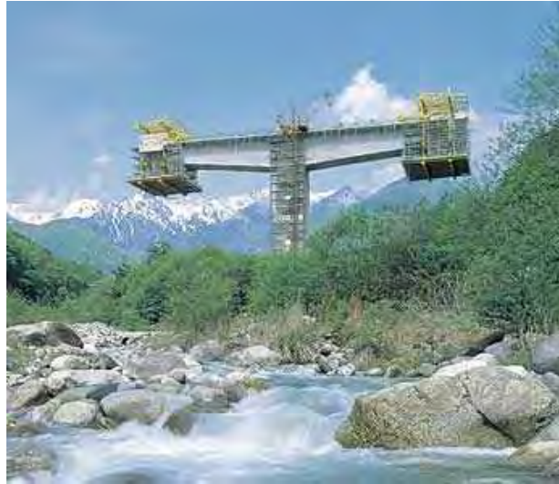
[図 4.1.1] バランスドカンチレバー工法による道路橋の架設状況
