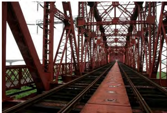
この橋は複線橋として建設されたものの、橋梁の前後区間は単線である。これはこの付近で強風が吹くため耐風安定性も考慮して幅の広い複線橋とされたとのこと。
