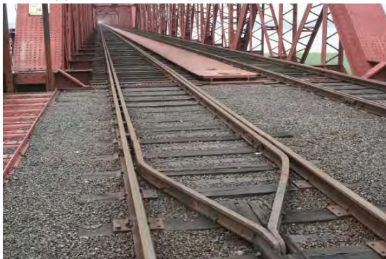
ジャムナ多目的橋には設置されていない(複合軌道のメーター軌側に脱線防止ガードの効果を期待とのこと)が、この橋には設置されていた。
