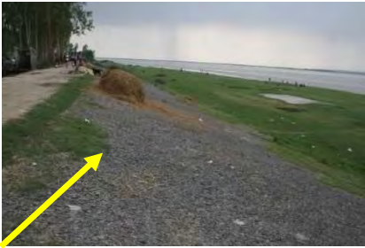
41. 東側ハードポイントでの護岸工
