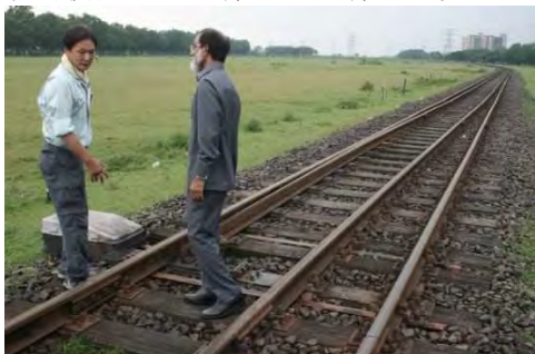
橋上では4線軌条の複合軌道になっている。
