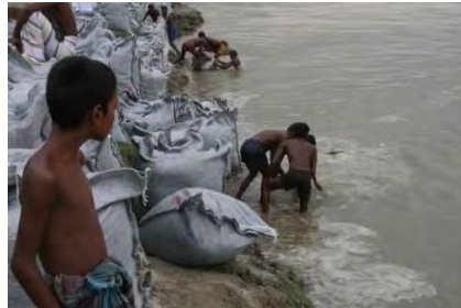
42. 東側ハードポイントでの土嚢の投入
