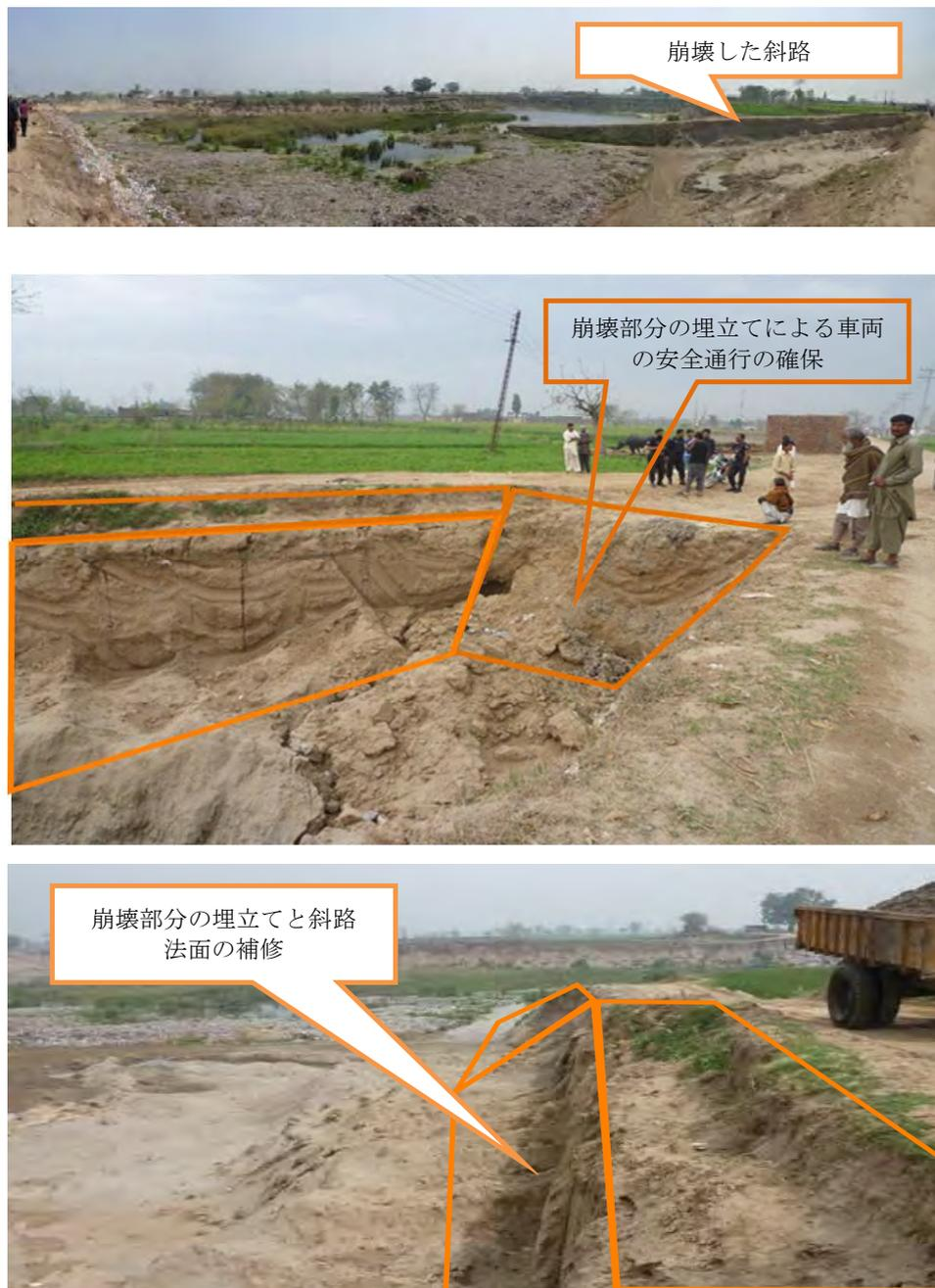
写真 4.5.1 ゴンドランワラ埋立地の崩壊部分
