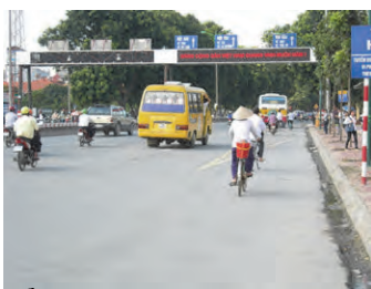
Biển VMS trên ĐVĐ 3 tại Mai Dịch
