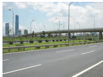
NG trên tuyến Láng-Hòa Lạc
