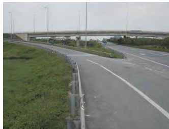
Nút giao Bắc Ninh
