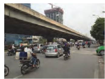
Cầu vượt trên ĐVĐ 3 tại Trung Hòa
