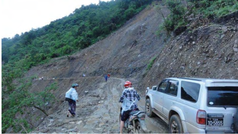
図 4.11 NO.27 102/1-2 道路恢復旧状況
