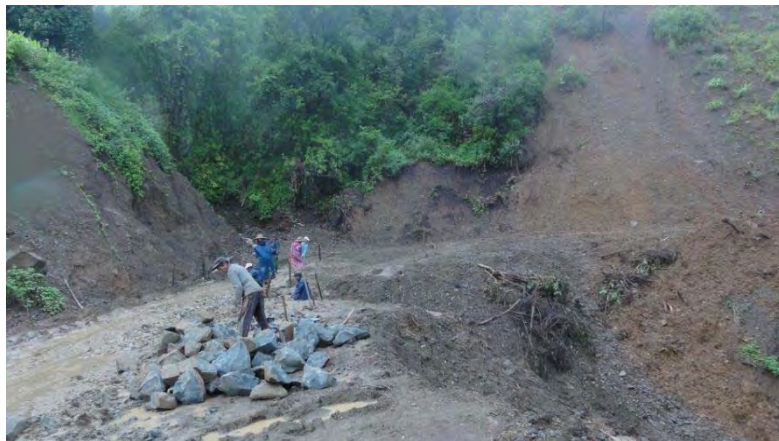
図 4.13 94/4-5 道路整備作業
