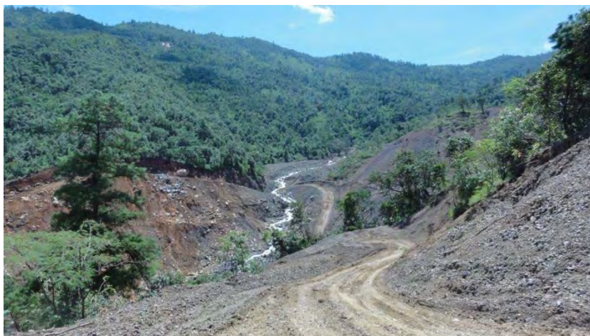
図 4.15 ハッカ～ガンゴウ道路の仮復旧状況 (17/5-18/2)
