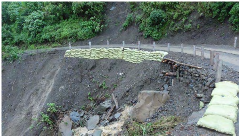
図 4.12 96/4 土のう等による路肩補強
