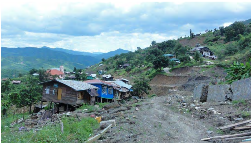
図 4.21 ハッカ市内被害状況(1)
