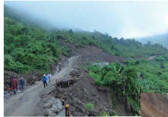
No.23 (97/0-1) カテゴリ-A-2 崩積土地すべり、道路欠損、周 辺道路沈下
