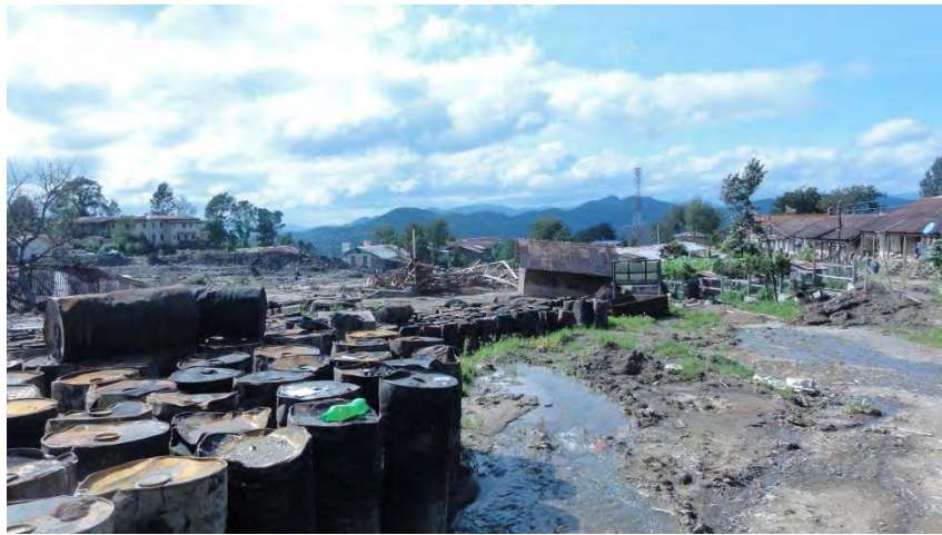
図 4.20 ワークショップの被災状況(2)
