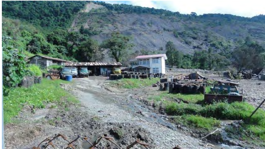
図 4.19 ワークショップの被災状況(1)
