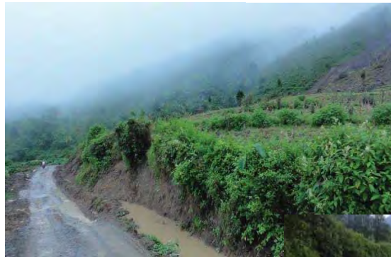
No.24 (97/3-4) カテゴリ-A-2 崩積土地すべり、道路沈下
