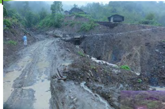
No.25 (100/4-5) カテゴリ-A-2 沢部土石流による侵食、道路欠損
