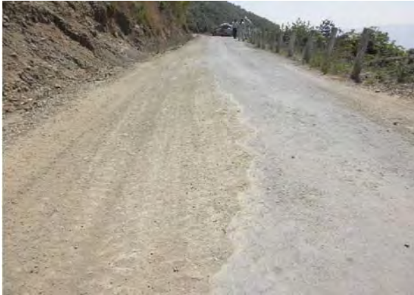
チン州整備対象道路の様子(1)
