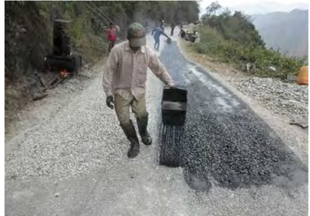
チン州整備対象道路の様子(2)
