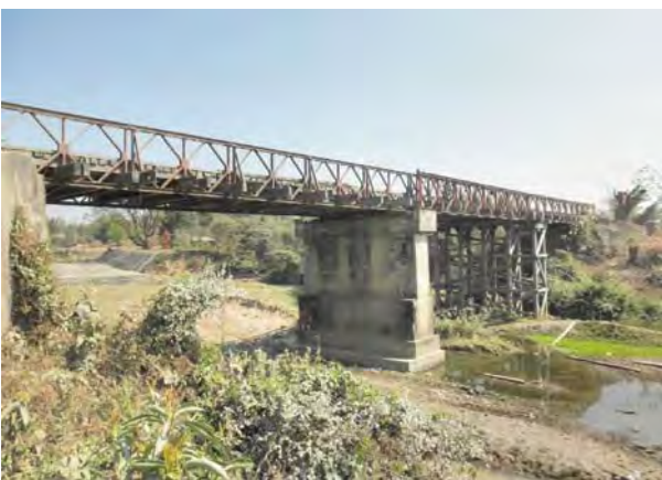
カチン州整備対象道路上の既存橋梁(1)
