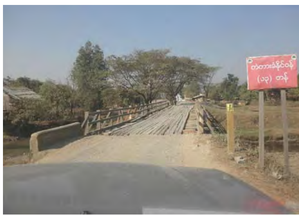
カチン州整備対象道路上の既存橋梁(2)
