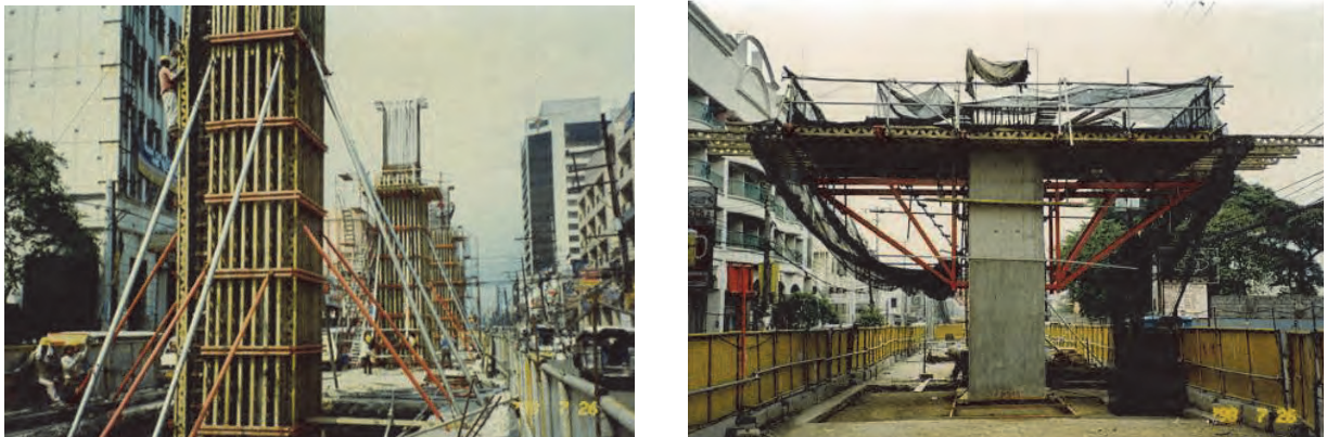
図 5.1.2 橋脚の施工状況（LRT2 号線の例）
