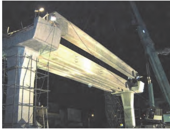
図 5.1.5 シングルトラッククレーンによる桁架設状況（LRT1 号線延伸事業の例）
