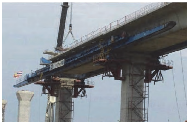
図 4.4.9 ガーダー架設工法の事例
