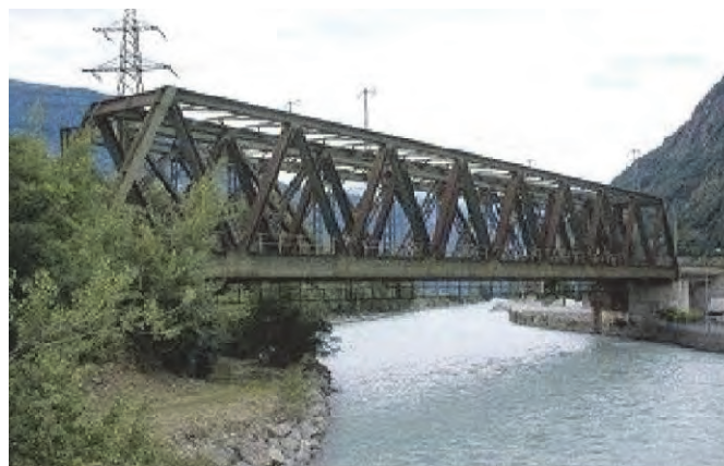
図 4.4.14 トラス橋梁（写真）
