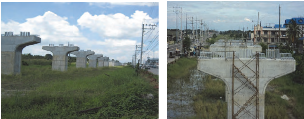
図 4.4.18 ノースレール事業の残置構造物の例
