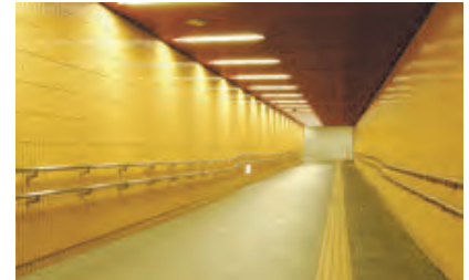
スロープと二段手すりの例
