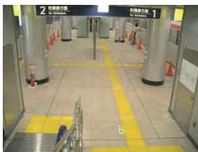
点字ブロック
