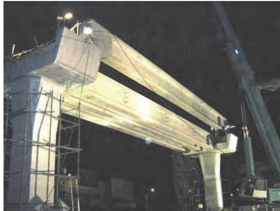
図 5.1.5 シングルトラッククレーンによる桁架設状況（LRT1 号線延伸事業の例）
