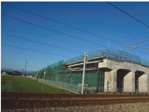
図 5.1.6 固定支保工架設工法による施工状況の例
