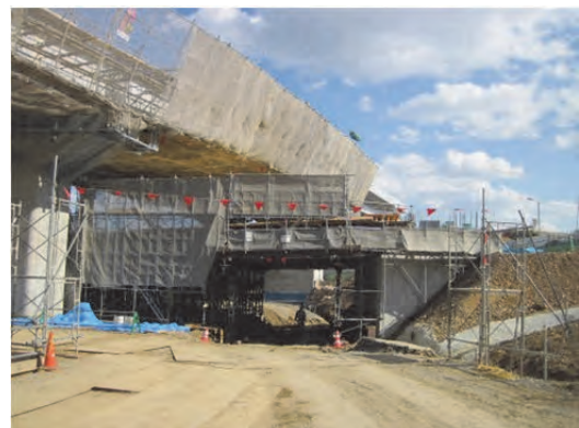
図 5.1.6 固定支保工架設工法による施工状況の例
