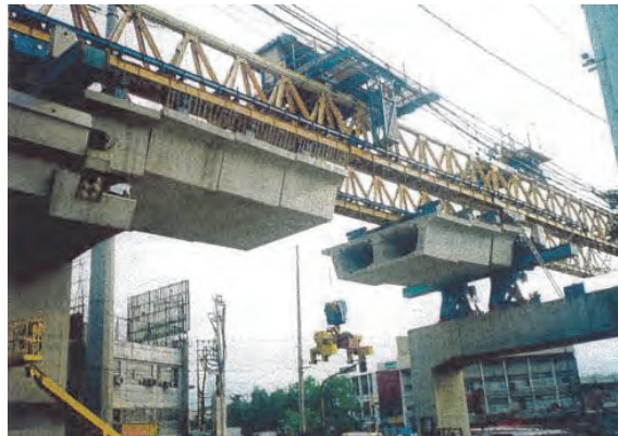
図 5.1.3 トラス式ガントリーによる PC 箱桁架設状況（LRT2 号線の例）
