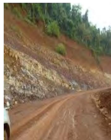
図 3.2-10 国道沿い切土法面のチャンパ層露頭
