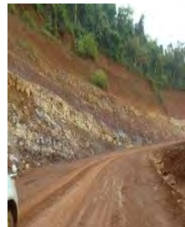
図 3.2-10 国道沿い切土法面のチャンパ層露頭
