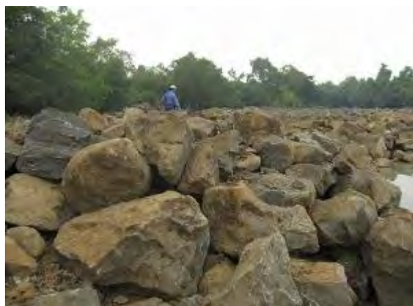
砕石プラント近傍の玄武岩の床掘り
