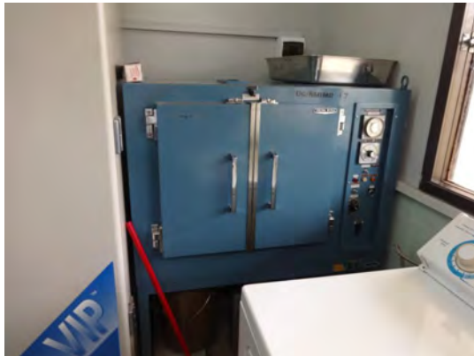
写真 2-15 乾熱滅菌器 老朽化により更新が必要
