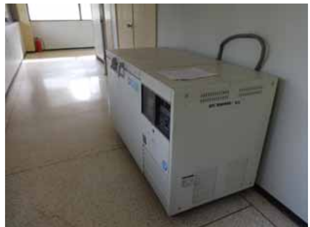
ウイルス学部門の超低温保冷库：1994年頃整備 され機材で老朽化し正常に稼動していない
