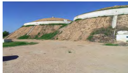
Photo 5 Bassins de distribution
