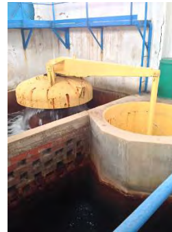
Photo 3 Bassin mélangeur (droite) Photo 4 à l'intérieur du bassin mélangeur
