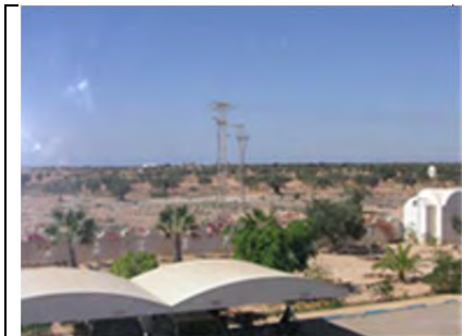
Photo 14 Tour d'alimentation de la STEG
