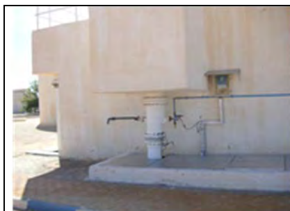
Photo 17 Débitmètre de prise d'eau
