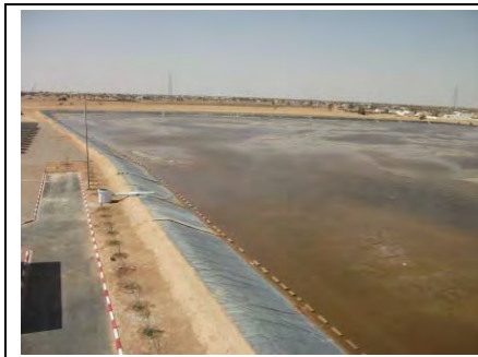
Photo 32 Lit de séchage au soleil
