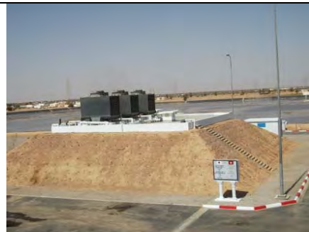
Photo 33 Tour de refroidissement
