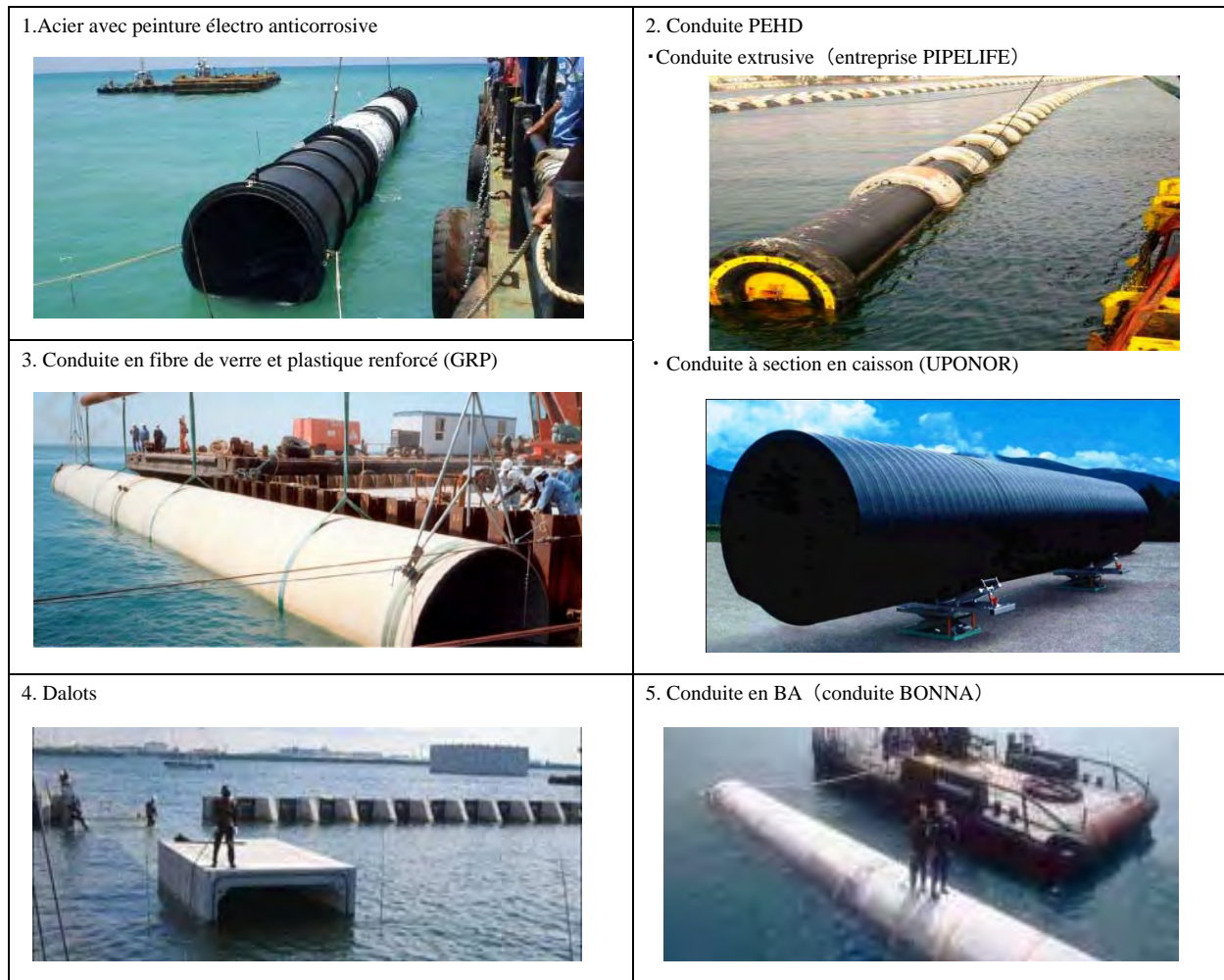
Figure 5.5-5 : plusieurs types de conduites sous-marines.
