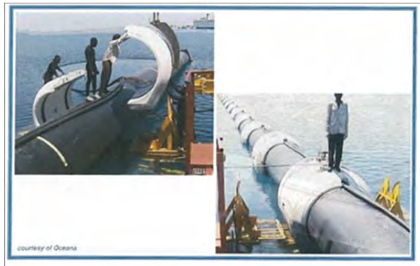
Figure 5.5-3 Conduite en PEHD, avec lest
