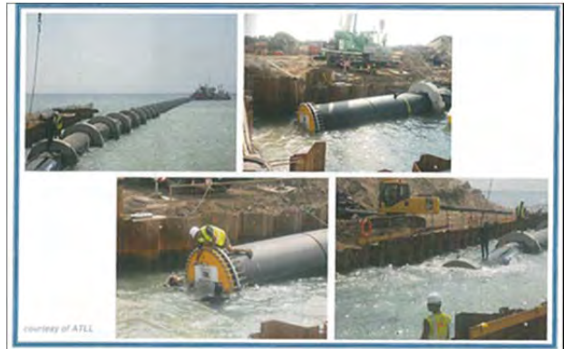
Figure 5.5-4 Construction conduites en acier
