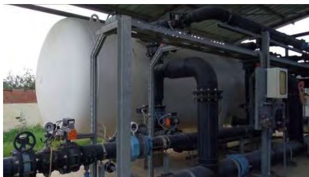
写真2 砂ろ過器
