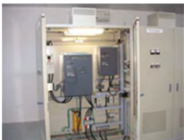
写真 39 動力制御盤
