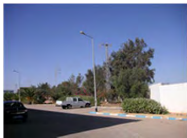
写真 26 受電 STEG 鉄塔
