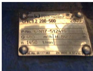
写真 4 RO ポンプ銘板
