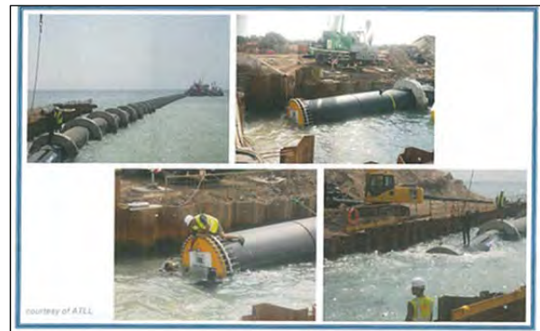
図 5.5-4 鋼管方式取水管工事風景
