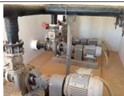
**Photo 35 Pompe de filtre, pompe de contre-courant**
