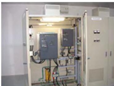
写真 39 動力制御盤
