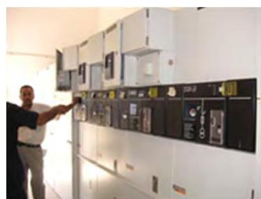
写真 16 電気室配電盤
