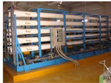
写真 38 RO 膜処理設備
