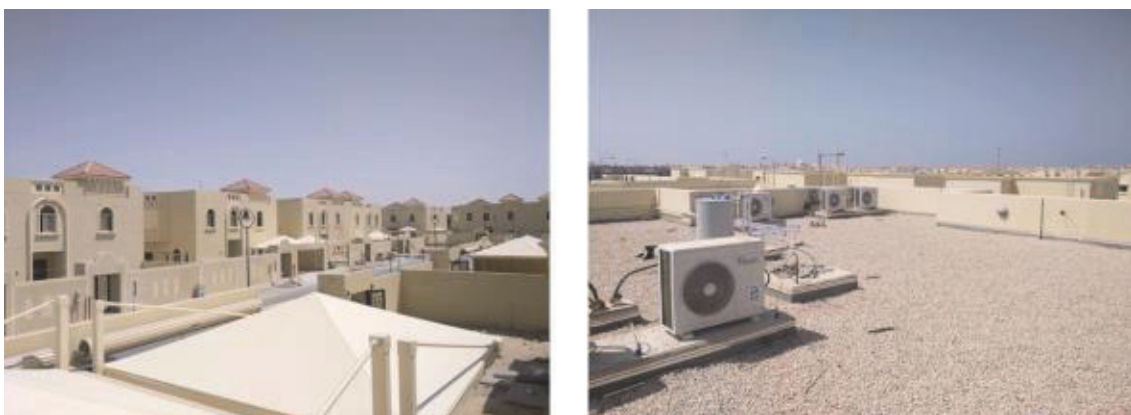
図 3.4.3-1 SABIC 職員住宅（左） 職員住宅屋根状況（右）
