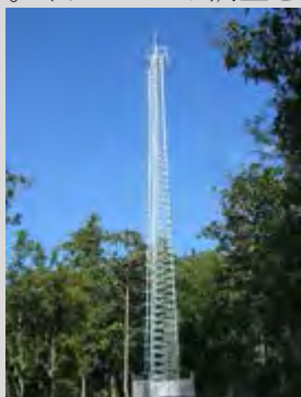
WiMAX に使用する完成後のタワー
